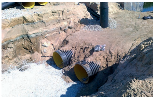
Lægning af Krah DN/ID1000 rør på byggeplads.
