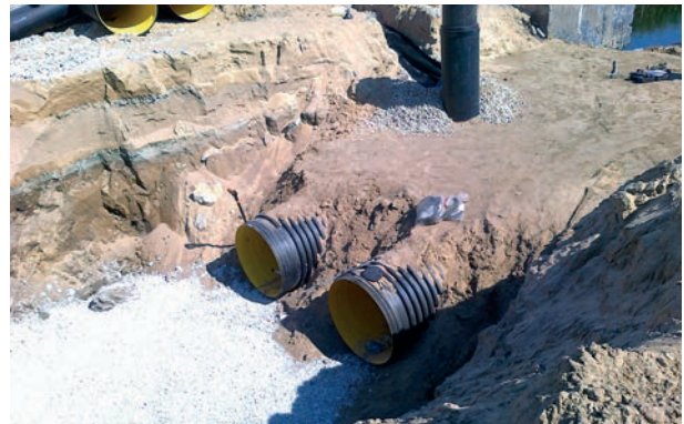
Krah putkien DN/ID1000 asennus kohteessa
