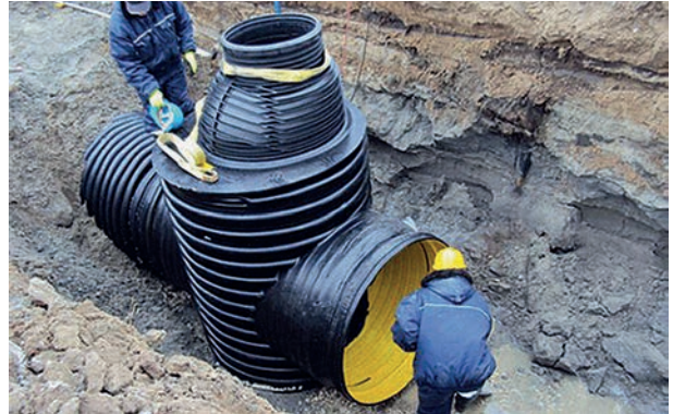
Sadeveden tarkastuskaivo DN/ID1500
