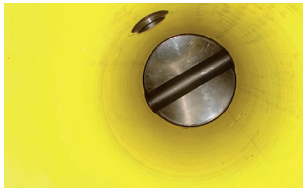
Viemärin tarkastuskaivo DN/ID800
