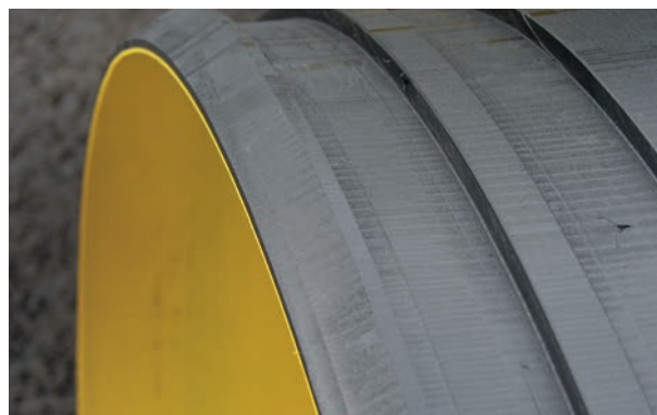
Kumitiivisteiden juonteet putkessa
