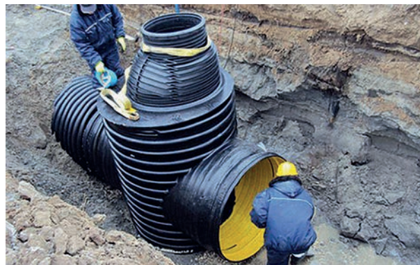
Studzienka drenażowa rewizyjna DN/ID1500
