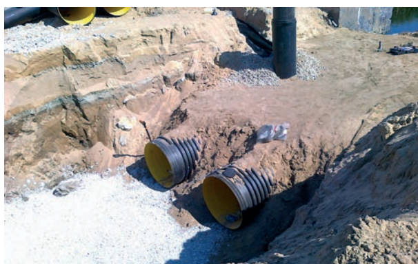
Układanie rur Krah DN/ID1000 na obiekcie
