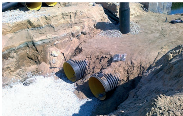
Installation av Krah-rör (DN/ID1000) i anläggningsområdet
