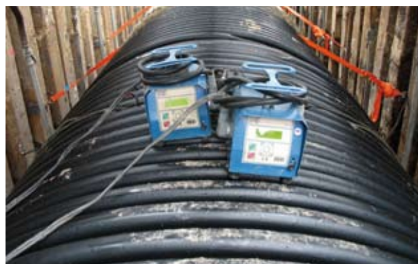
Suurediameetrilise toru keevitamine kitsas kaevikus
