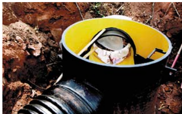
Standardne kontrollkaev DN/ID 1000 mm
