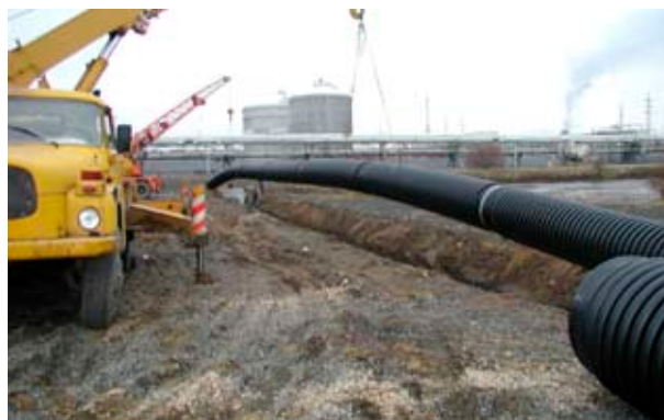
Eelühendatud torusegmendi paigaldus
