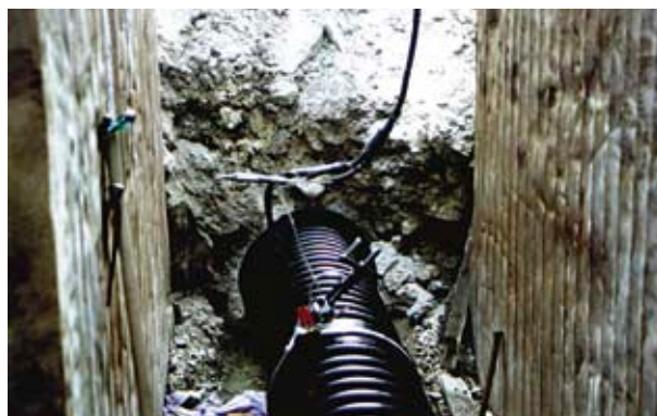
Betoontorustiku ennistamine toru-torus meetodil
