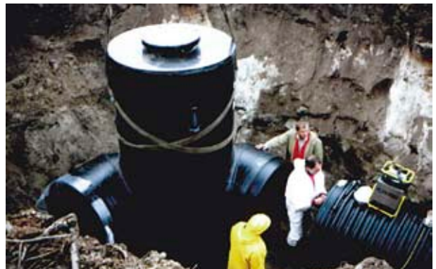
Integreeritud poogna ja elektrikeevismuhvidega kontrollkaev
