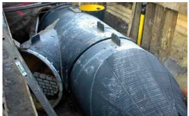
Üleminek DN/ID 2400 mm → DN/ID 1600 mm
