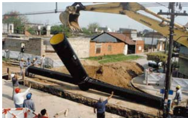
Integreeritud kontrollkaevu paigaldus
