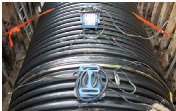
Elektrikeevisühendus paigalduskohas
