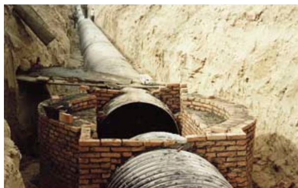
Krahtoru ühendus tellistest kontrollkaevuga
