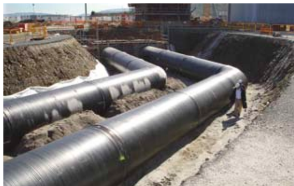
Kahe torujuhtme paigaldus koos fittingutega DN/ID 2000mm
