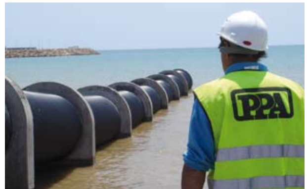
Uputatava torusüsteemi paigaldus Hispaanias
