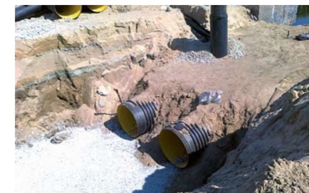
Krah torude DN/ID1000 paigaldus objektil
